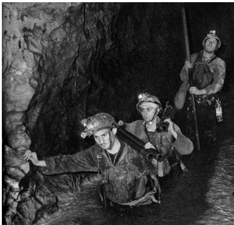
Figure 20 : Transport de mât dans le gouffre Berger en 1954. Noter la frontale électrique faite d'une torche coupée pour le spéléo au premier plan. Source : Opération -1000 (photos entre pages 176 et 177). {7}
